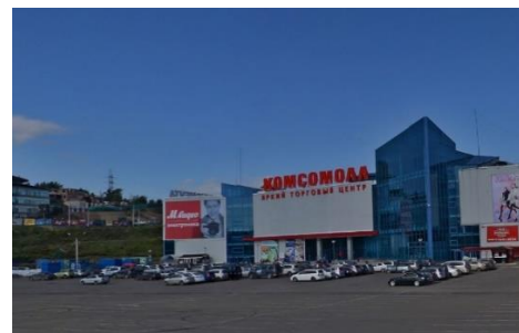
ТРЦ «5-я Авеню» Москва 40 000 кв. м.
